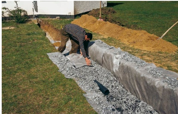
Abb. links: Anschluss des Versickerungsrohrs.
