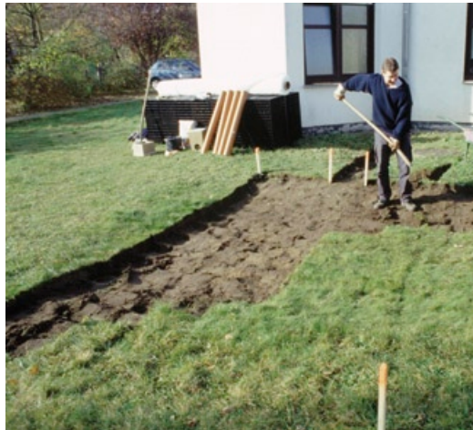
Abb. links: Abstecken der Baugrube.
