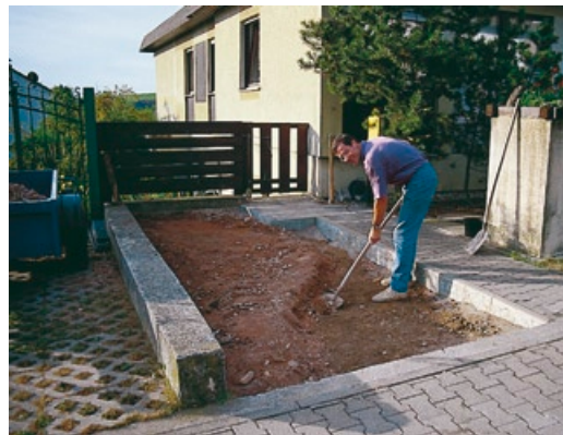
Abb. links: Randsteine setzen.
