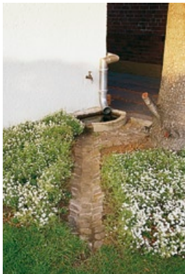
Abb. oben: Regenwasserversickerung in einer Mulde.
