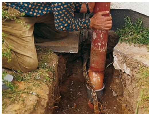
Abb. rechts: Anschluss an Hofablauf.
