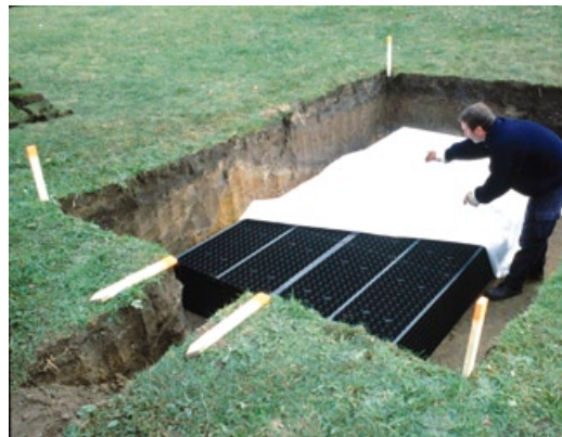
Abb. links: Einsetzen der Kunststoffelemente.
