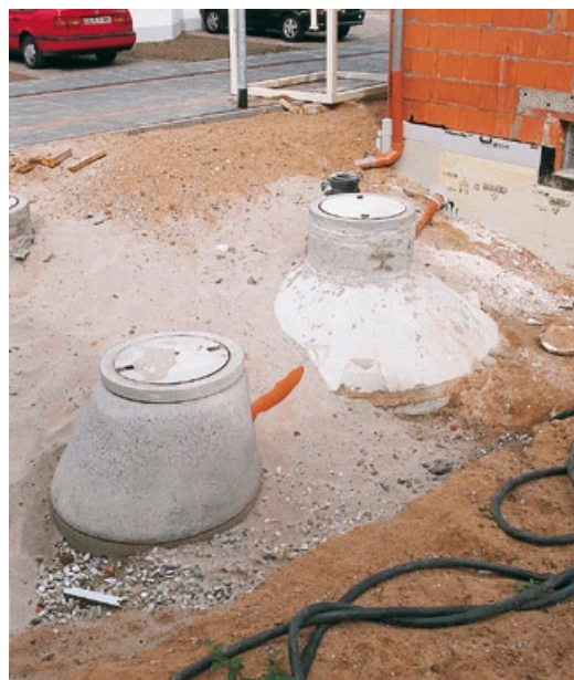
Abb.: Regenwasserspeicher kombiniert mit Versickerung.
